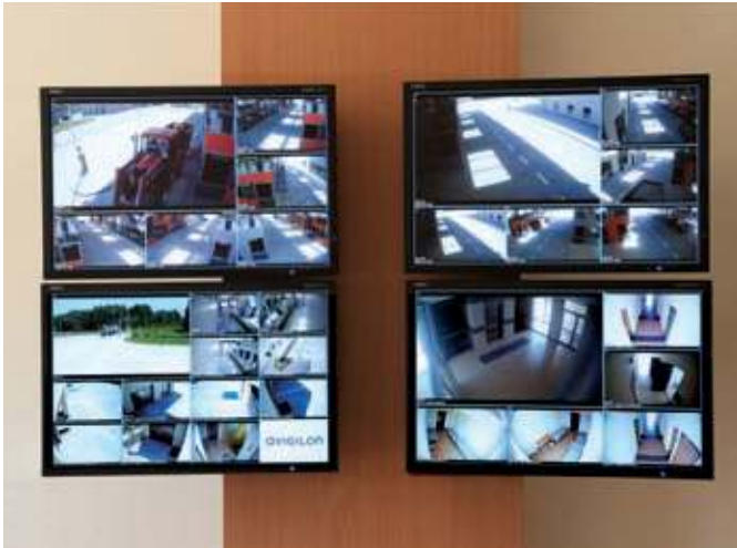
Budomierz / Monitoring - Drogowe Przejście Graniczne
