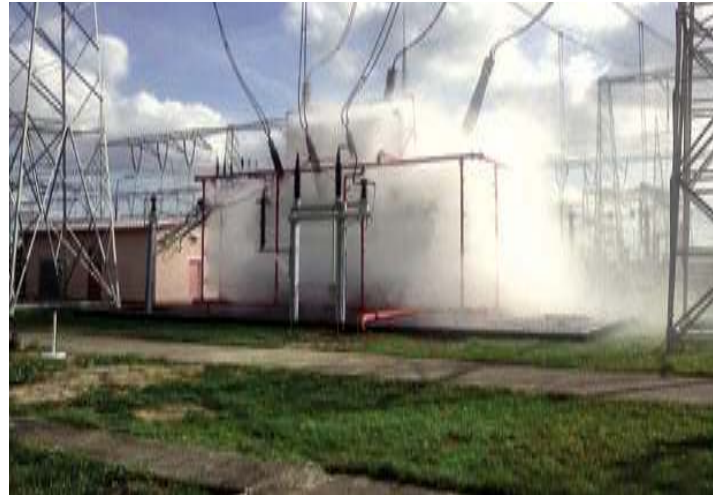
Gaszenie Stacji Transformatorowej
