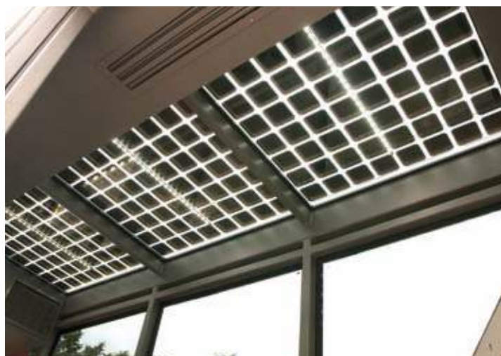
Rzeszów / Fotowoltaiczny przystanek autobusowy-wnętrze
