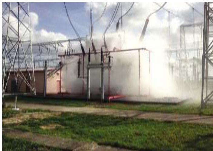
Gaszenie Stacji Transformatorowej
