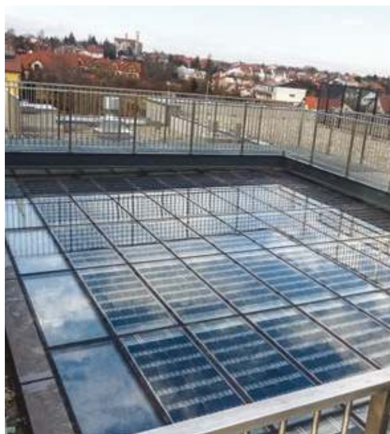
Rzeszów / Archiwum Państwowe / Moduły NoFrost zastosowane w świetliku
