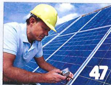
Montaż modułów fotowoltaicznych
