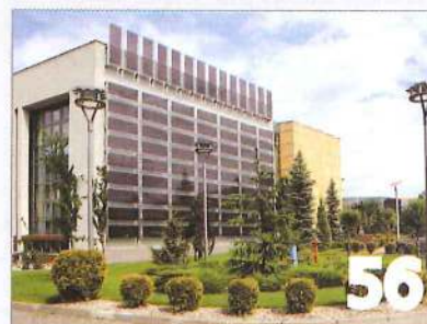
Instalacja PV na budynku Wyższej Szkoły Prawa i Administracji w Rzeszowie
