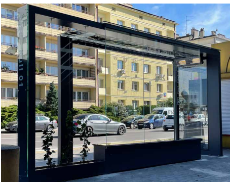
Fotowoltaiczna wiatka przystankowa, Rzeszów
