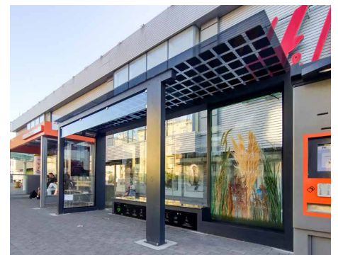
Fotowoltaiczna wiatka przystankowa, Rzeszów
